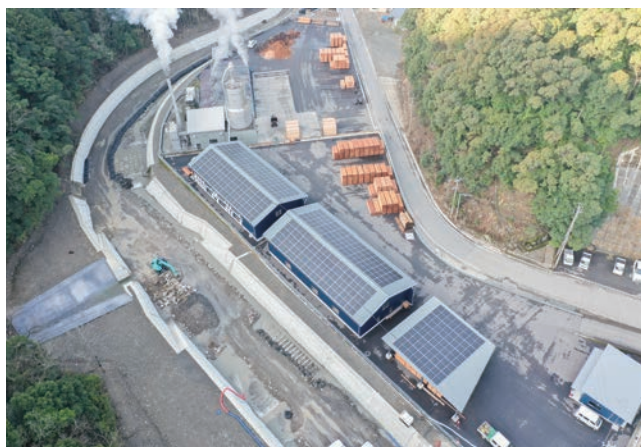
太陽光発電と木質バイオマスボイラーを備える製材所
